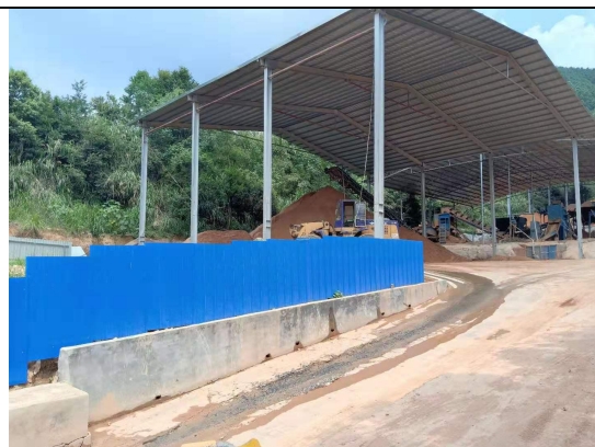
原料堆场三面围挡
