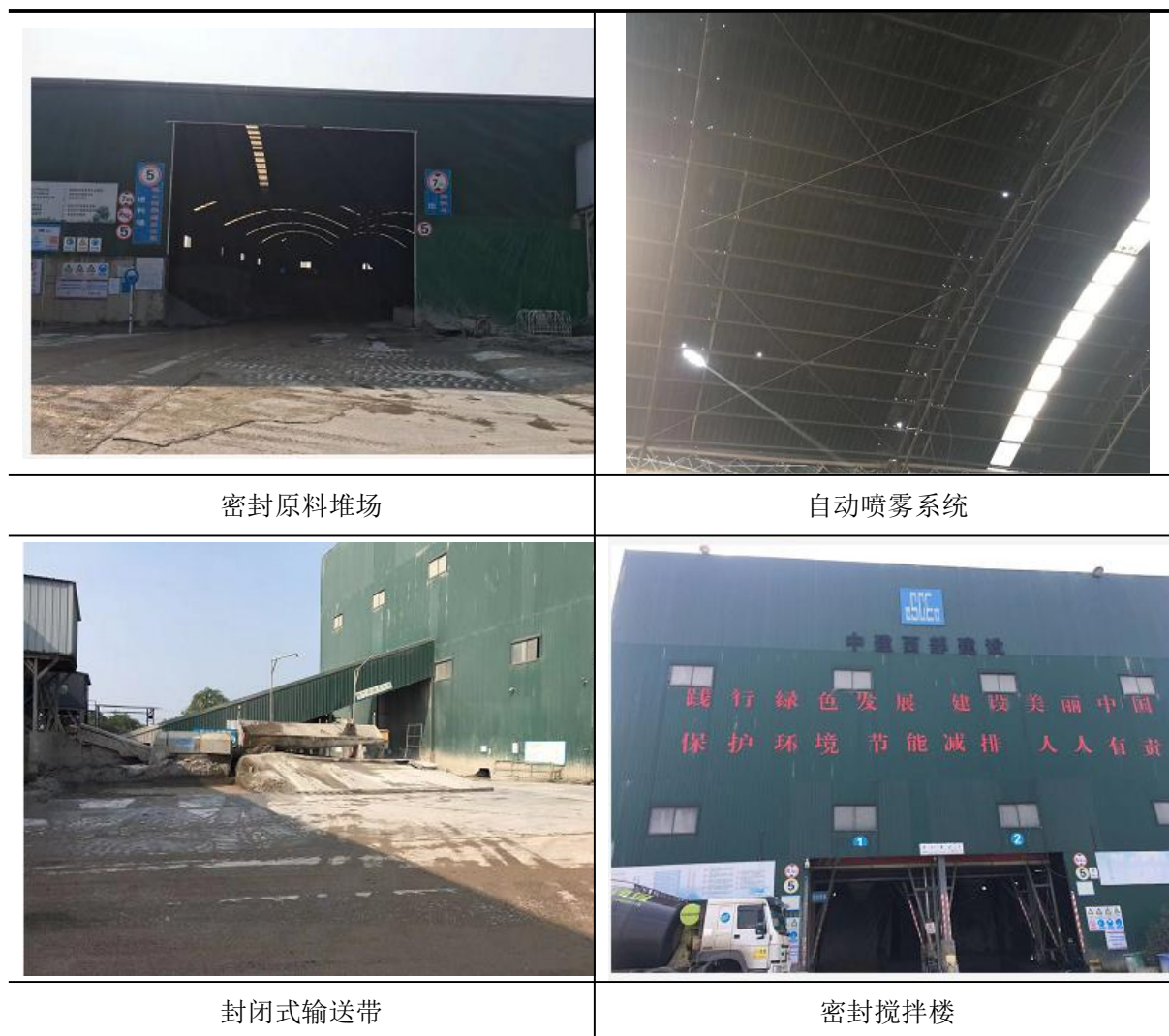
图 4-2 废气处理设施照片
