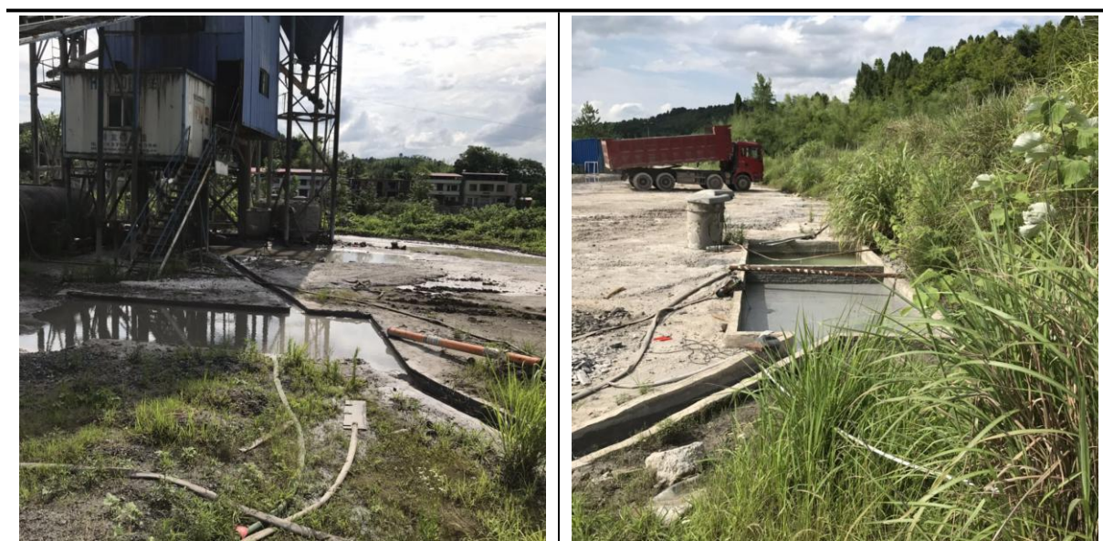
雨水沟+沉淀池
