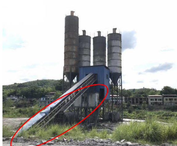
运输皮带封闭
