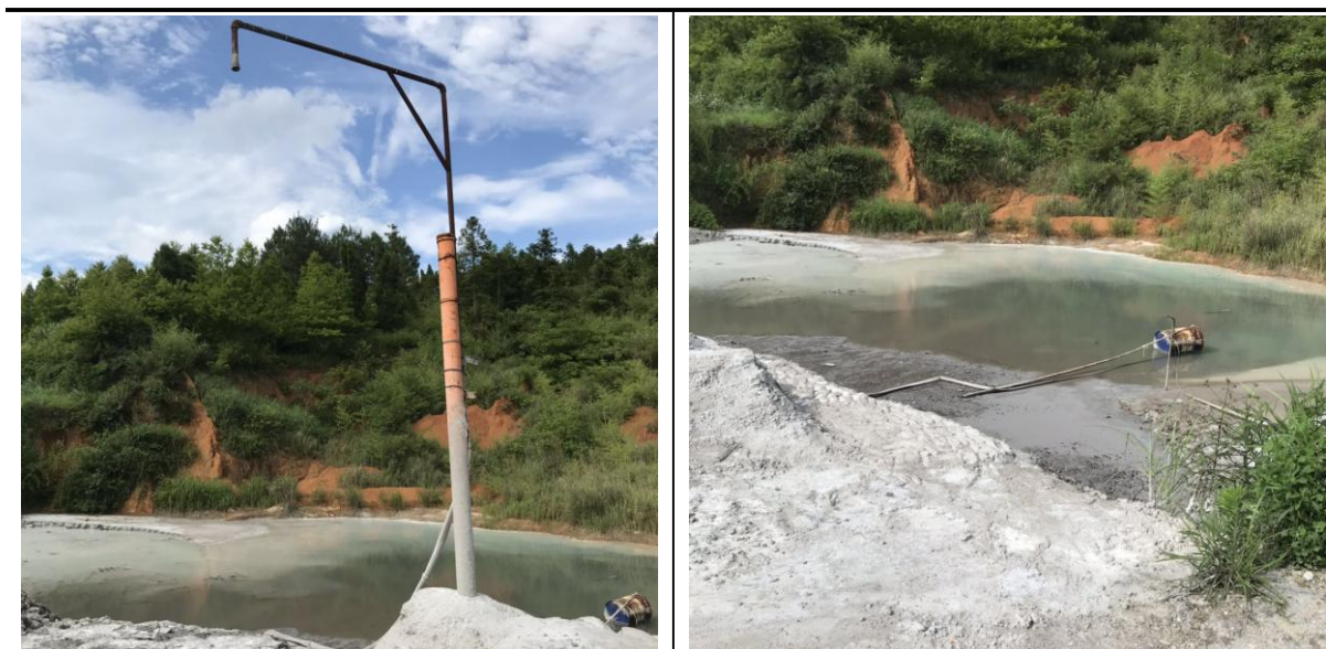
洗车设施+沉淀池
