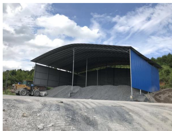
原料堆场顶棚+三面围挡
