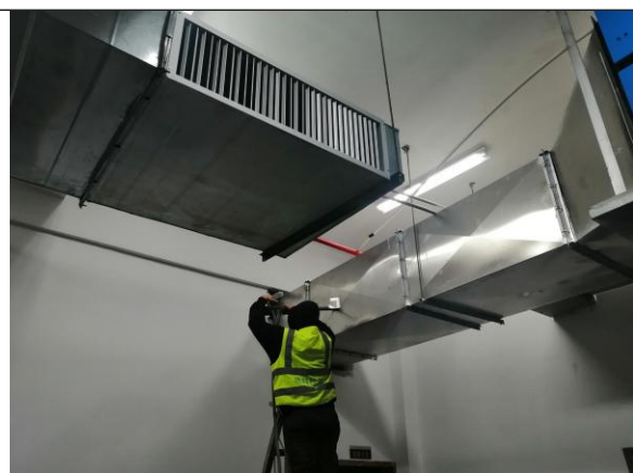
2#油烟废气排气筒出口
