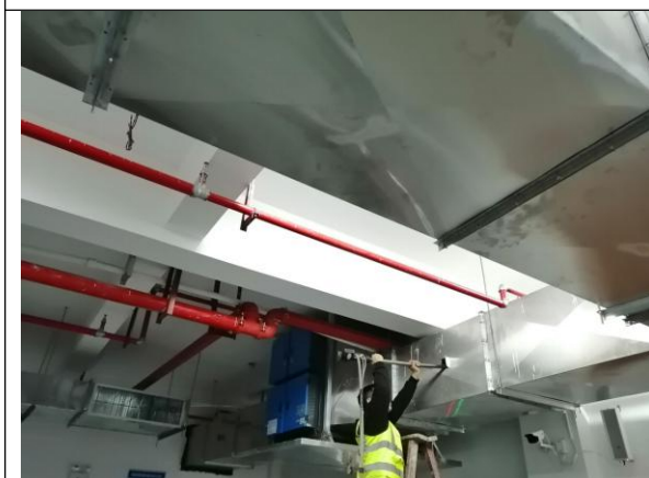
2#油烟废气排气筒进口
