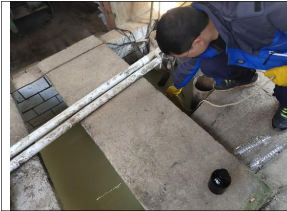
污水处理设施进口
