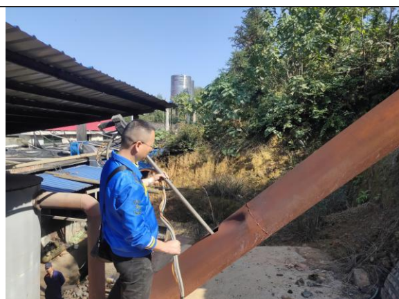
导热油炉废气排气筒出口
