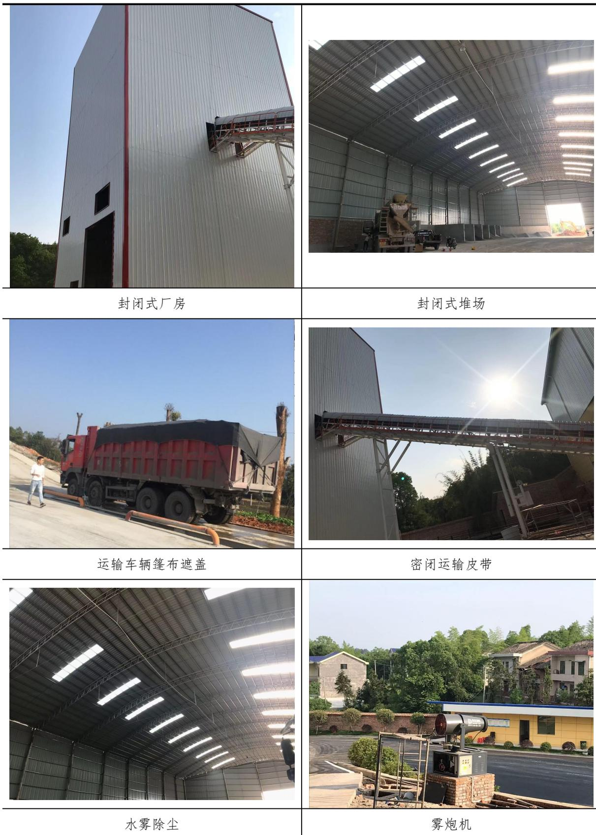
图 4-2 废气处理设施照片
