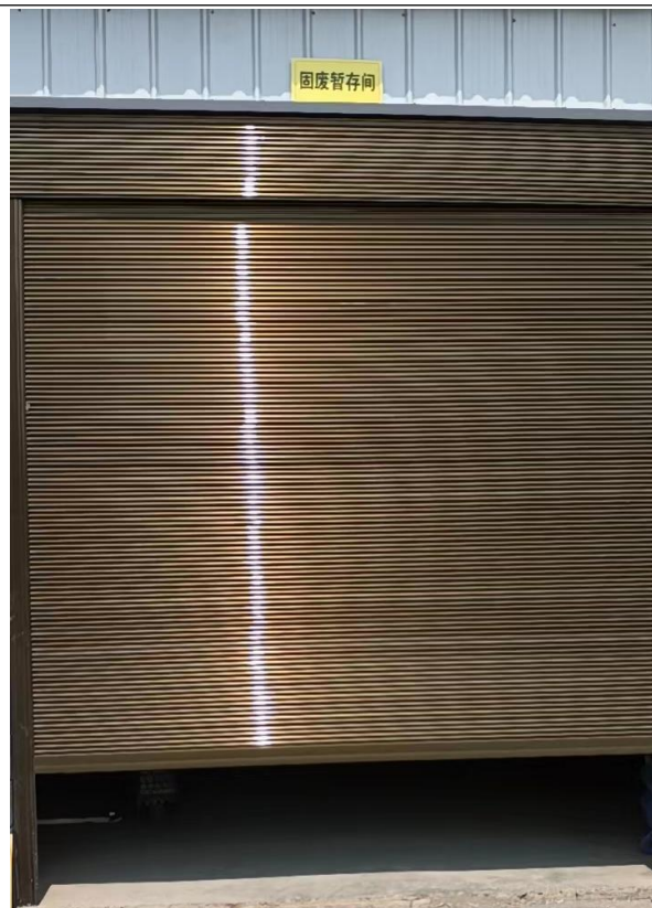
一般固废暂存间
